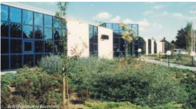
Bedrijfsgebouw in Beusichem
